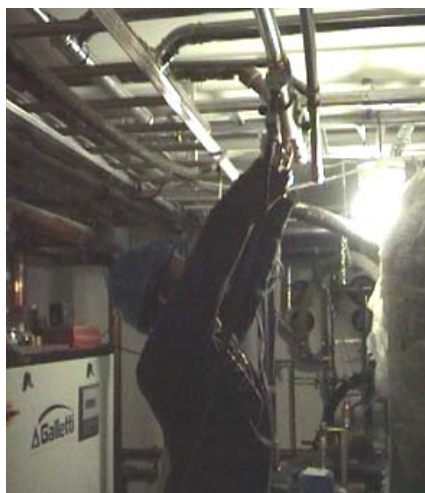
Figur 3: Illustration av rörmontörs arbete med att sammanfoga rör. Arbetet sker med armarna högt över huvudet med sträckta armar och kraftigt böjd rygg och nacke. (Hallén & Rose, 2006).
